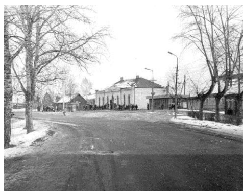
Рис. 4 Почтовая станция в Опочке на ул. Коммунальной. Общий вид. Фото В.А. Лебедевой. 1987 г.
