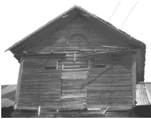
Ил. 3. Мезонин с прорезными причелинами, обломками ригеля-схватки и следами исчезнувшего балкона с двухскатной кровлей. Фото 1993 г.
